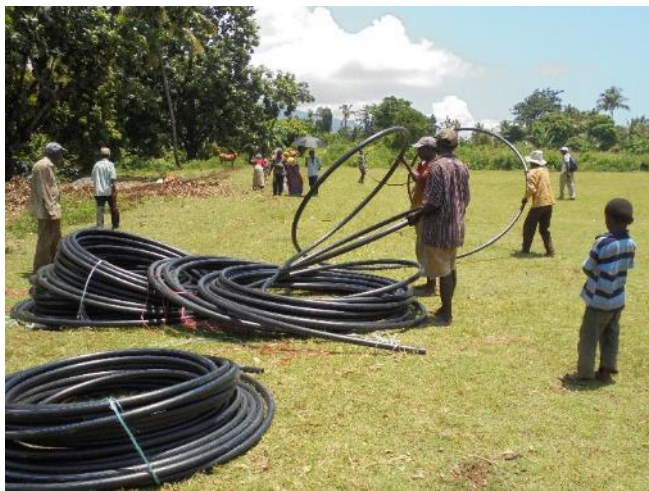
Travaux d'installation du Périmètre irrigué de Pomoni
